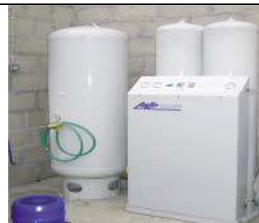
20 pav. Deguonies įpurškimo į vandenį įranga ( www.piscestt.com )
